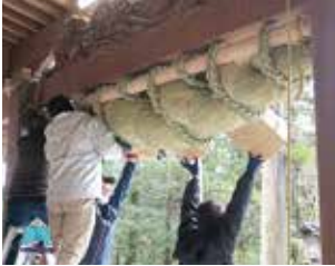
石橋棟梁による12月20日の取り付け作業
